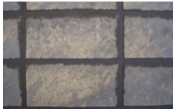
保水材を混入してない目地材の拭き取り前
