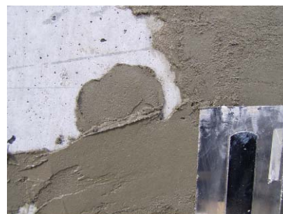
(写真7 NSダブルワン塗付け)
