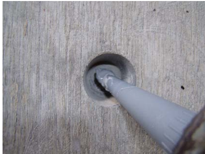
(写真5 防水処理)
