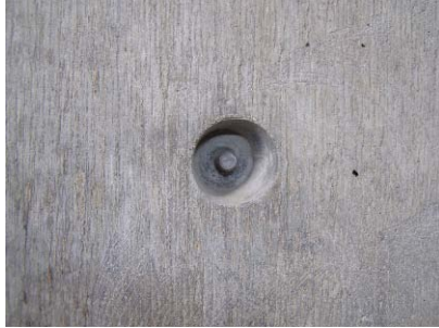
(写真4 プラスチックコーン除去)
