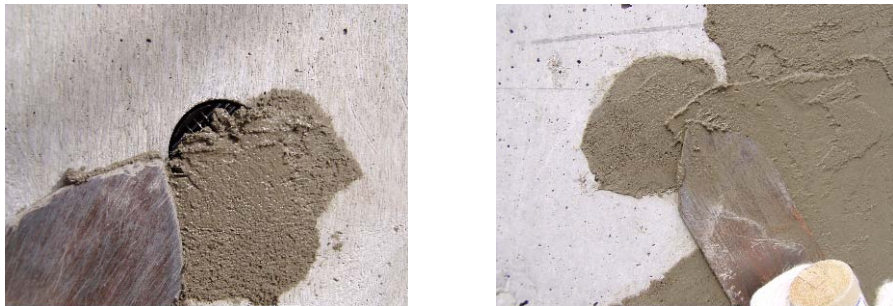
(写真8 NSポリマーミックス塗付け)
