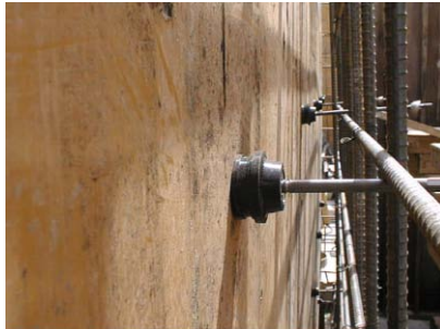
(写真2 スーパーloopボンド取付け)
