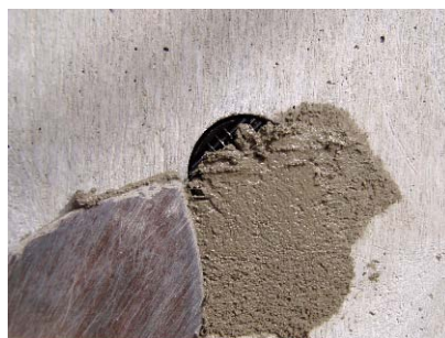
(写真7 NSダブルワン塗付け)
