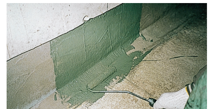
写真-3 Z-10立上り部施工
