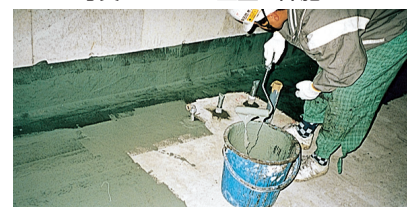
写真-4 Z-10平面施工
