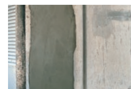
断面修復後[NSドカモルハード]
